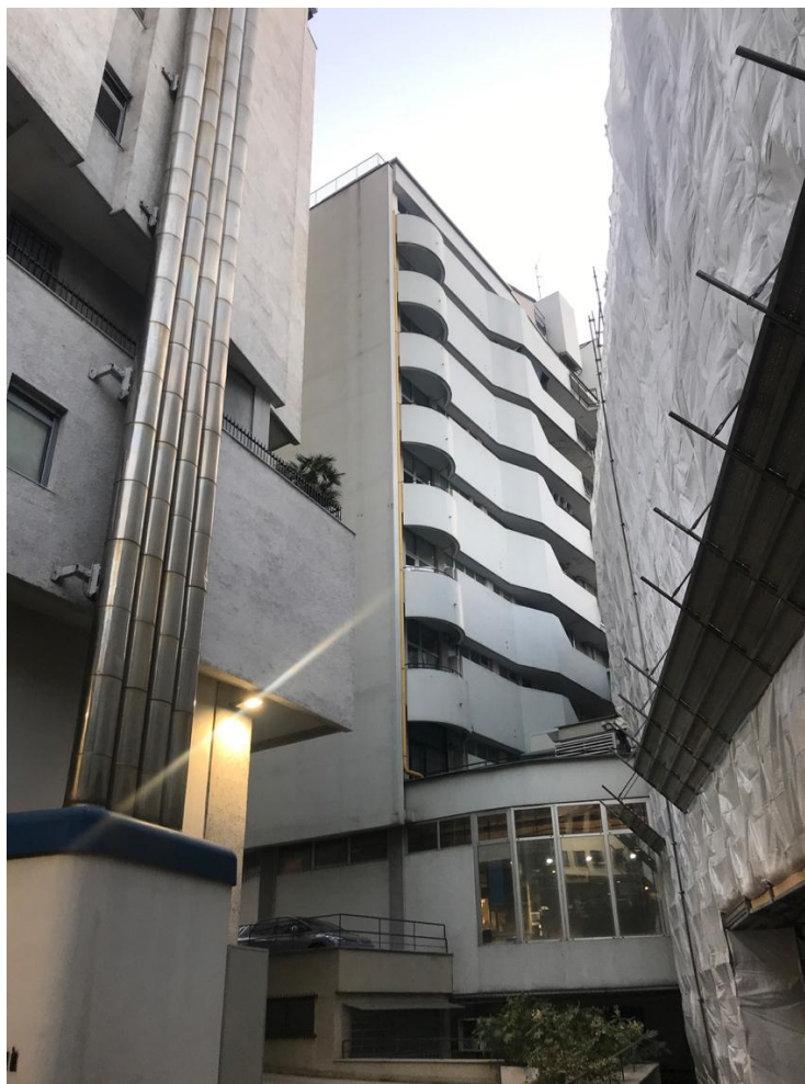
Fig. 3 - Luigi Moretti, Residenze in Corso Italia , Milano. Dettaglio della facciata dal cortile interno. Foto di S. Rugino. (2023)
